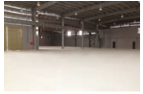
Usine d'aluminium, Dammam, Arabie saoudite
